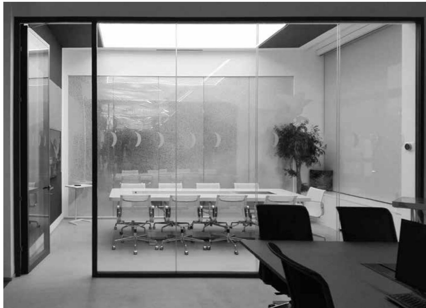
Parete divisoria continua vetrata con profilo guida “universale” che consente l’inserimento di pannelli ciechi in acciaio o in legno di 18 mm di spessore. Il profilo, in alluminio anodizzato o verniciato, ha dimensioni 85 mm in larghezza e 45 mm in altezza e prevede l’inserimento di lastre in vetro con spessori che possono variare dai 10 ai 12 mm. Lo stesso profilo può contenere una struttura in acciaio per la predisposizione di pannelli ciechi.
