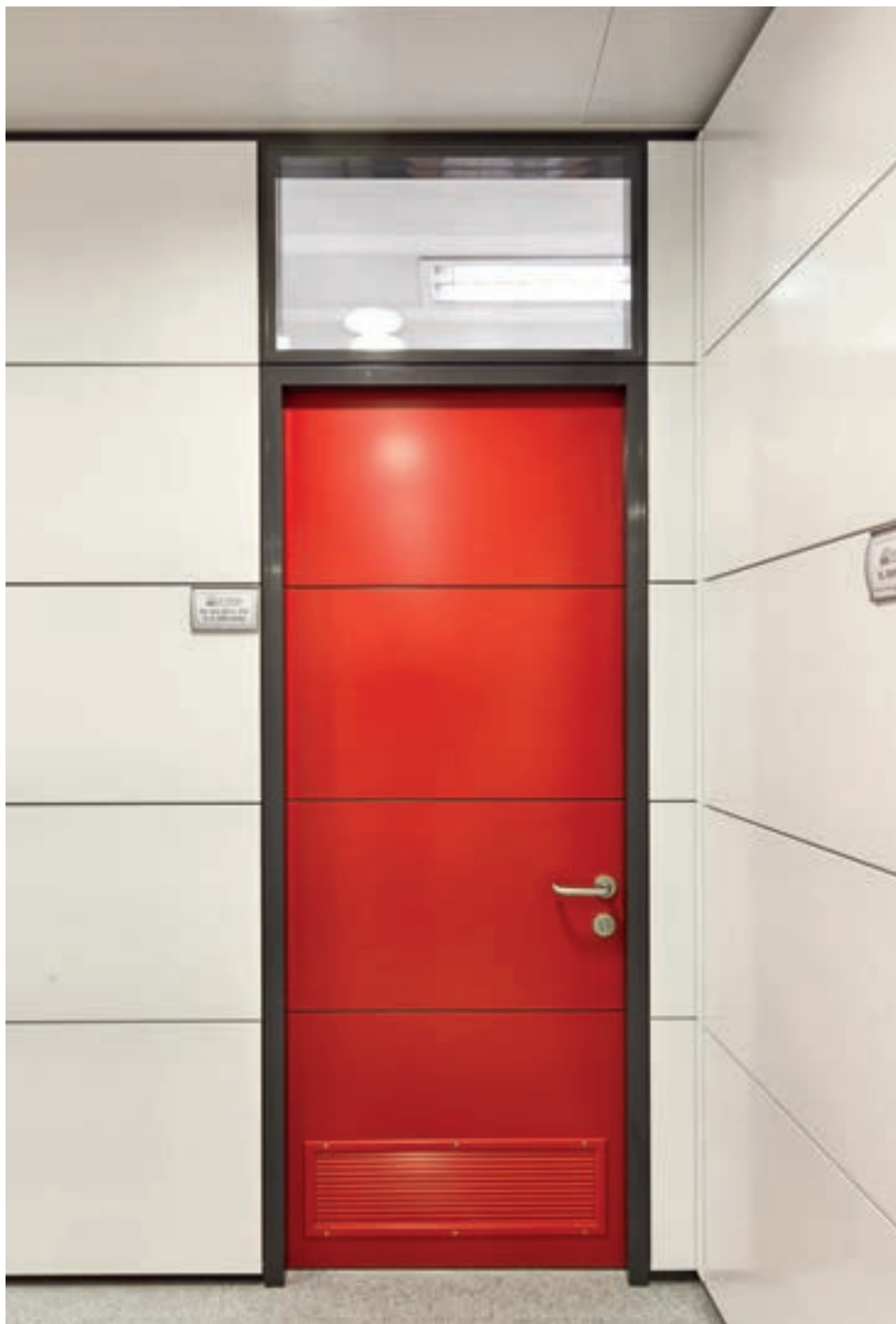
PORTA CON TELAIO IN ALLUMINIO E ANTA IN LEGNO WOODEN DOOR WITH ALUMINUM FRAME
