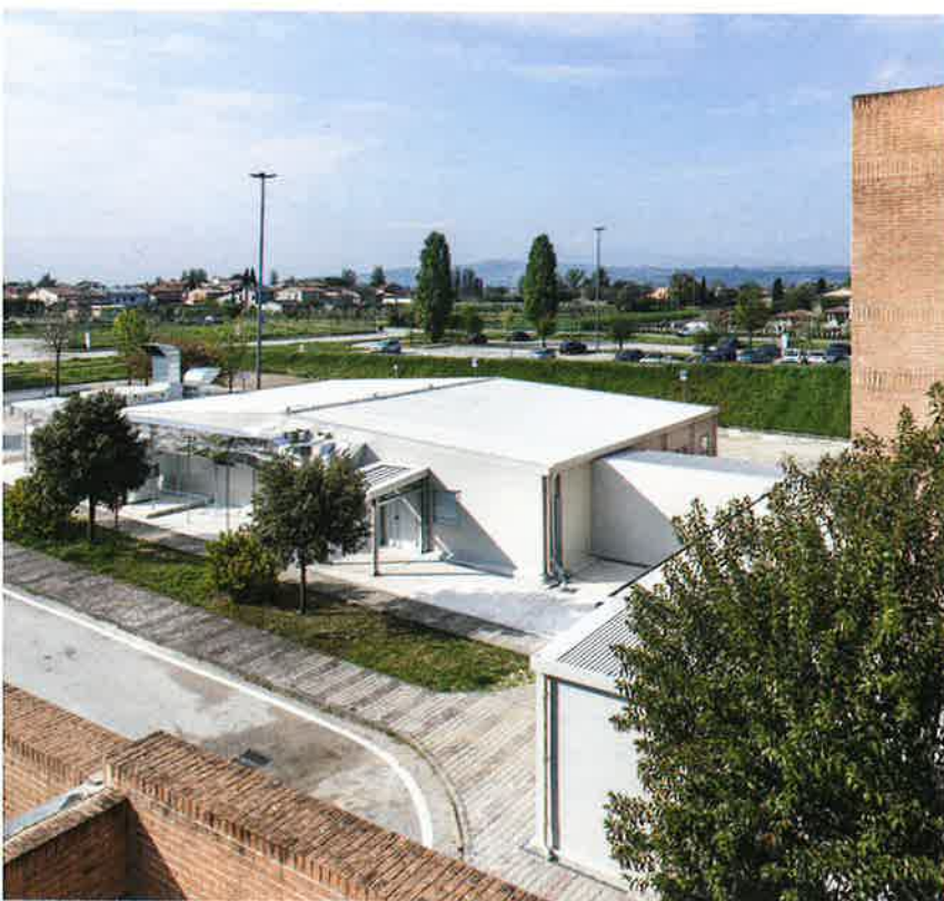
■ Modular Hospital realizzato a Foligno nel 2021
